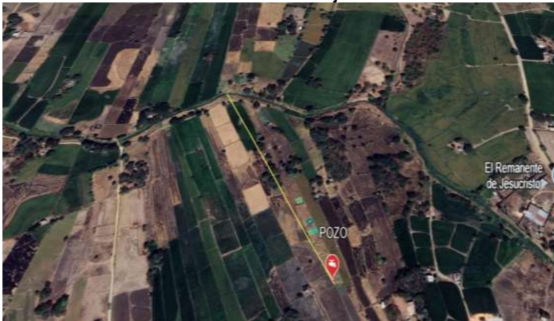
Figura 8. Deficiencia de canales de sistemas de drenaje.
